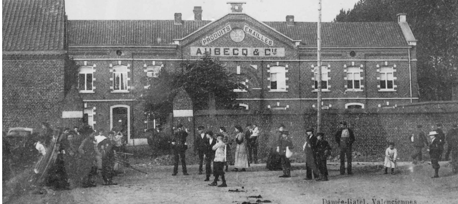
Ancien site des Établissements Aubecq à Blanc-Misseron.
